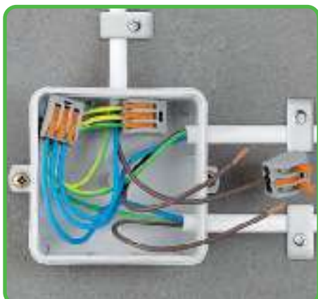
Прокладка тонких многожильных проводников в распределительную коробку.
